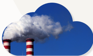
→ Cero Emisiones de Gases de Efecto Invernadero
